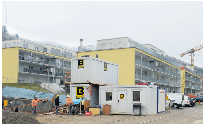
Noch sieht es rund um die Siedlung «Genesis» der CS-Pensionskasse nach Baustelle aus. Vermietet oder reserviert sind aktuell 22 von 75 Wohnungen.
